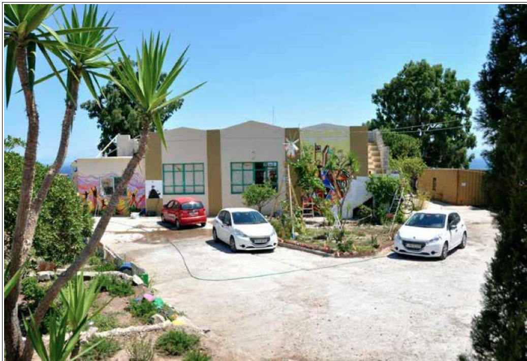
Ein Teil des OHF-Gemeinschaftszentrums auf Lesbos
